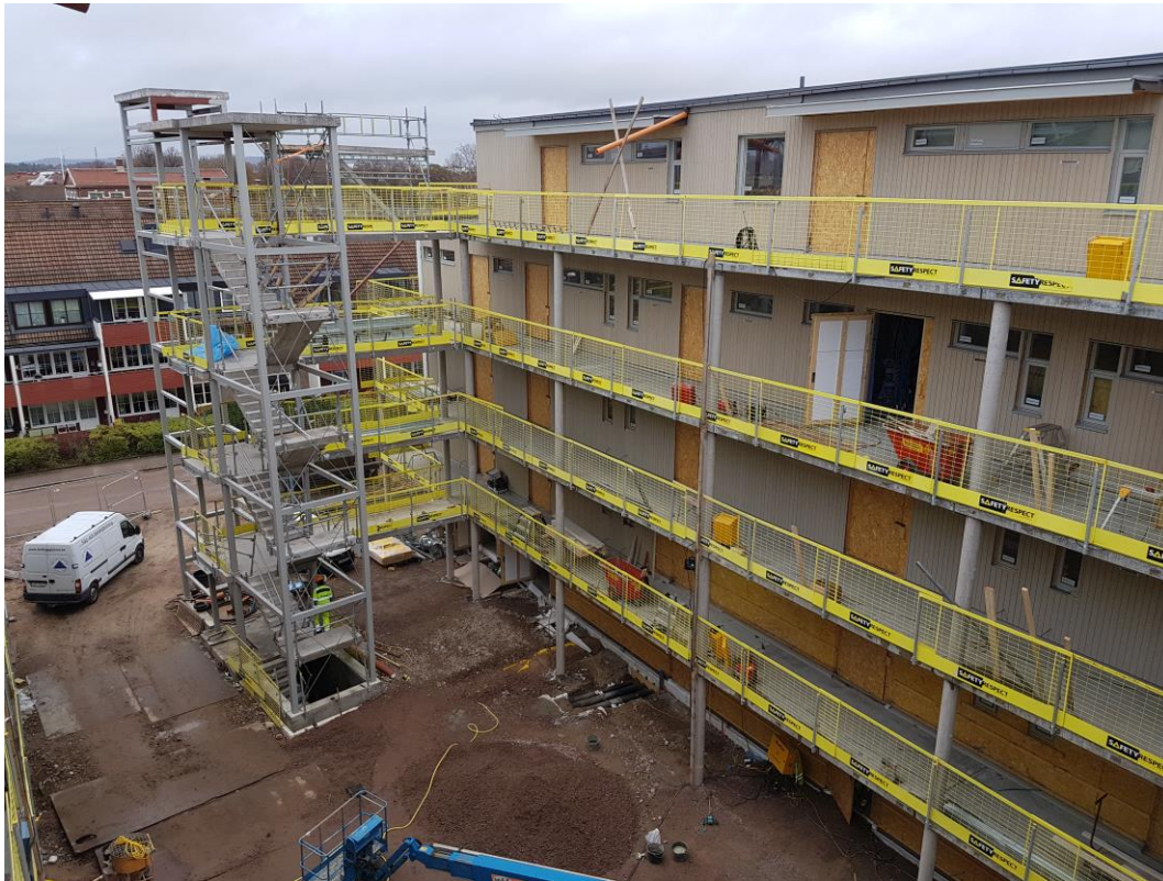
Bild från loftgång plan 5 mot "östra huset" (huset närmst mot högskolan)
